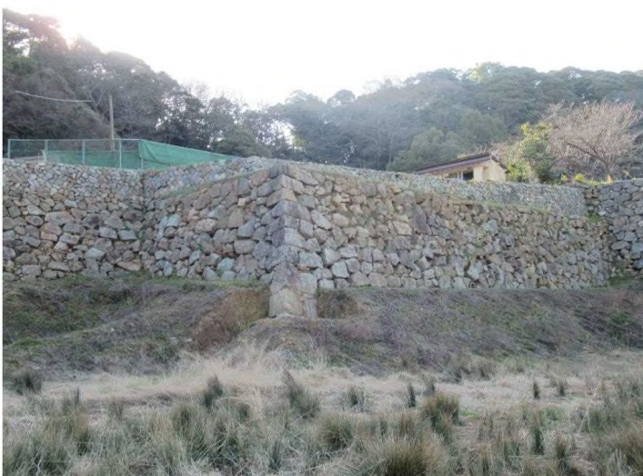
対象石垣現状（枅形側）
